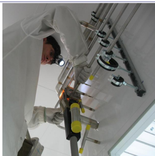
Фото 1: Орбитальная сварка трубопровода при настенном монтаже цеховой системы газоснабжения
